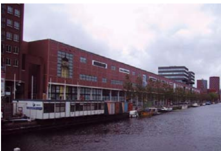
Praxis, Verheeskade, Den Haag
